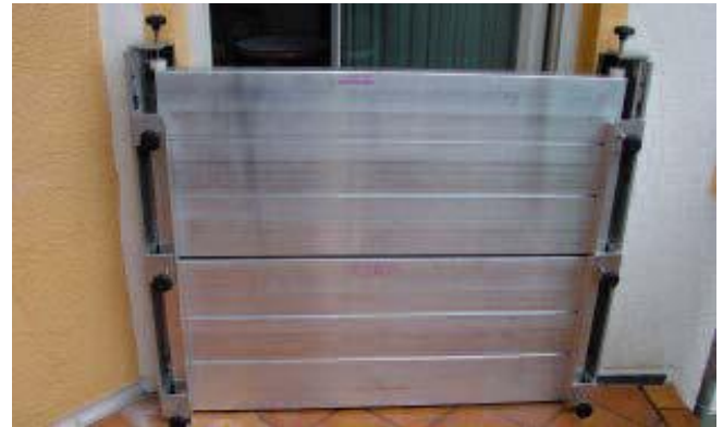
Beispiel für gebäudeseitigen Hochwasserschutz (Bild: Hochwasserschutzfibel des Bundesministeriums für Verkehr, Bau und Stadtentwicklung)
