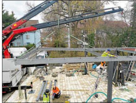
Ende November wurden die Stützen für die Dachkonstruktion des Radhaus aufgebaut.
