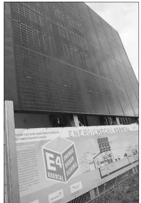
Die Photovoltaik-Verkleidung ist Teil des vierfachen Energiekonzeptes des Heizkraftwerkes.
