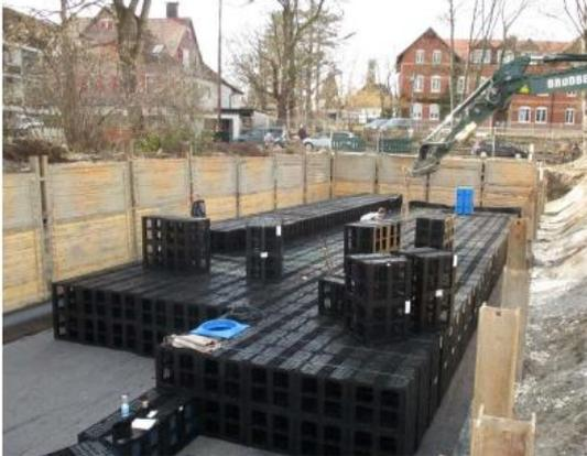
Abbildung 15: Bsp. für Rigolen Stadtmitte Korntal zur Retention.
