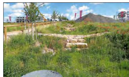
Unterirdische Kanäle führen das Regenwasser zu den Kaskaden in der Mitte von Korntal-West, um die Kanalisation zu entlasten.
