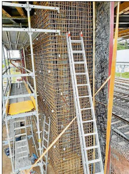
Nachdem der Beton jetzt seine Festigkeit erreicht hat, konnte die massive Betonwand endlich ausgeschalt werden und die Arbeiten am Oberbau können fortgesetzt werden. Als nächstes werden die Arbeiten zur Wiederherstellung des Korrosionsschutzes an dem Stahltragwerk sowie Stahlbau- und Betonierarbeiten an dem Überbau und den Brückenkappen durchgeführt, die dann später die Fahrbahn und den Rad-Gehweg bilden.
