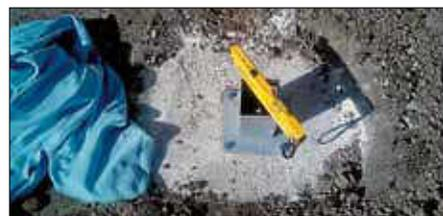
Nun konnten die Hülsen aufgesetzt und ins Wasser gesetzt werden. Nach dem Verschrauben wurde nochmal auf den geraden Sitz in beiden Ebenen geachtet.
